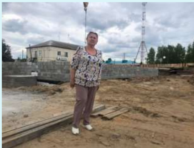
Строительство амбулатории г.п. Малиновский
